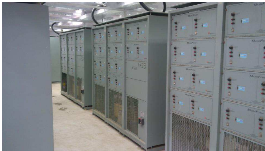
Figura 17 - Retificadores instalados.
