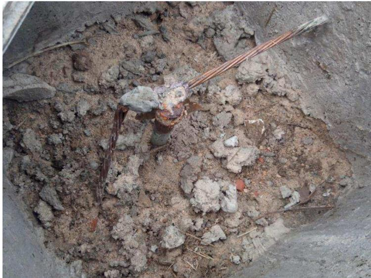
Figura 25 – Solda exotérmica haste/cabo.
