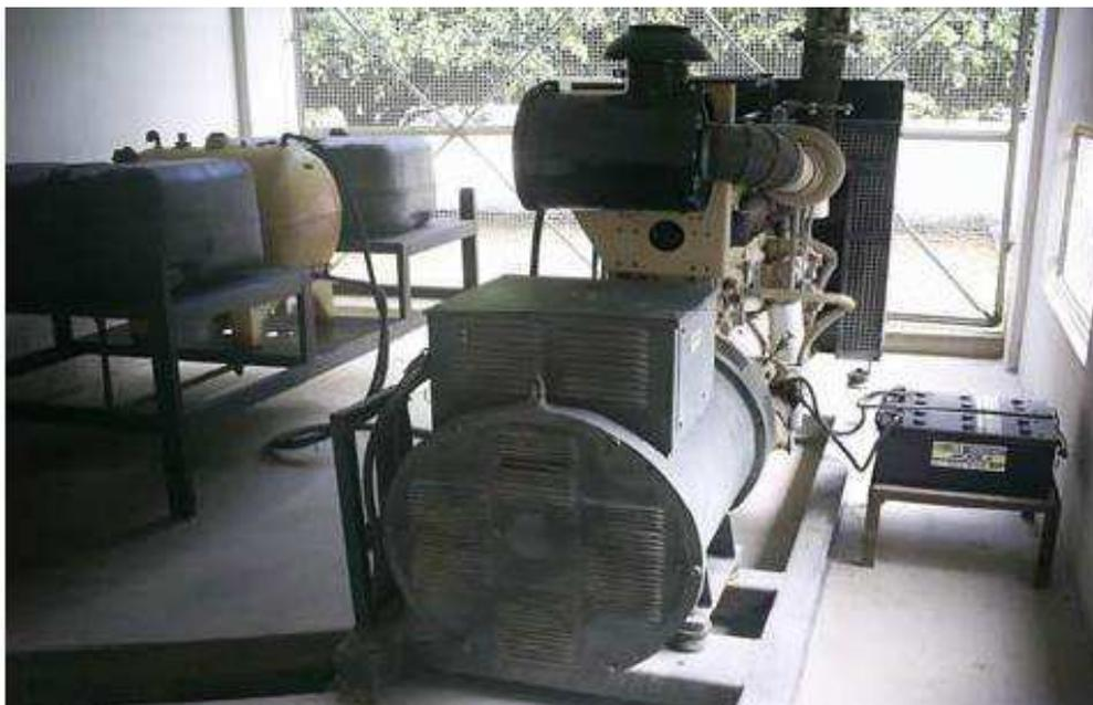
Figura 16 – Gerador de 450kVA.
