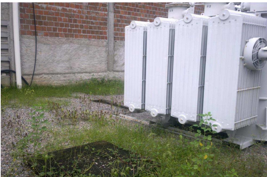
Figura 17 – Subestação 69 kV (limpeza geral da brita e pintura das bases dos equipamentos)
