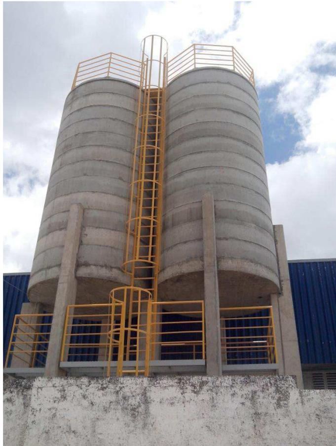
Figura 30 – Caixa d'água com ausência de um SPDA.
