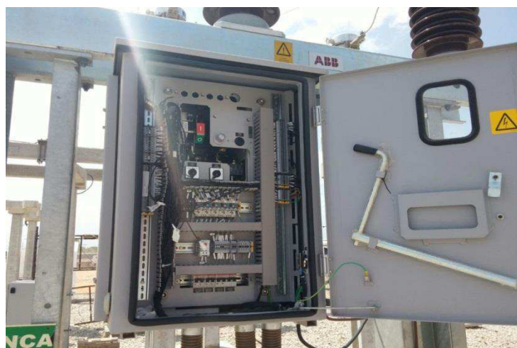
Figura 22 - Caixa de comando do disjuntor com os cabos de BT anilhados e etiquetados.
