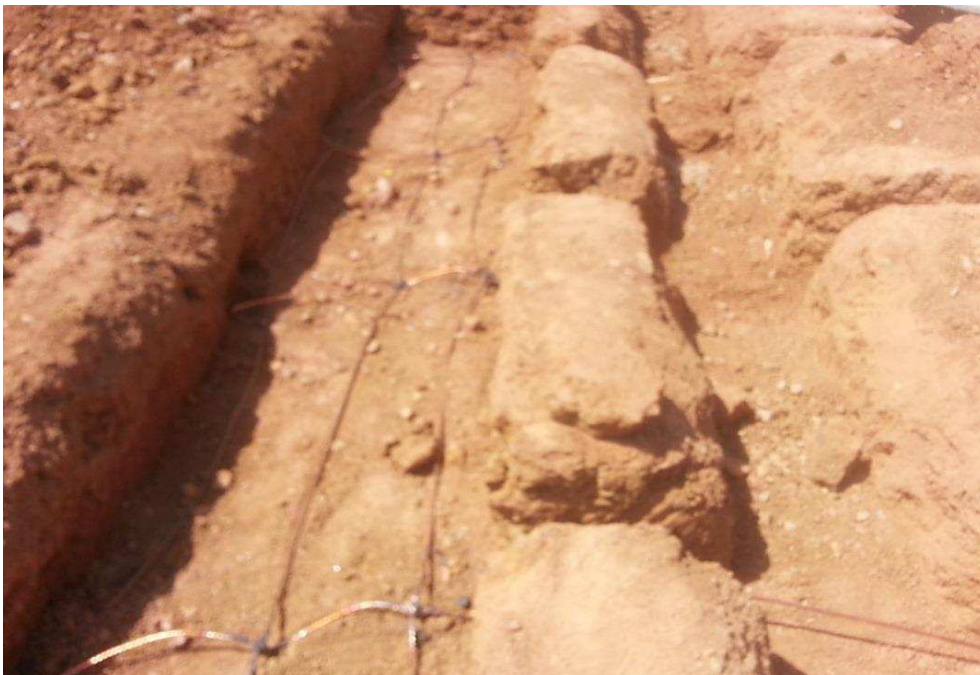
Figura 12 – Trecho da malha de aterramento finalizado.
