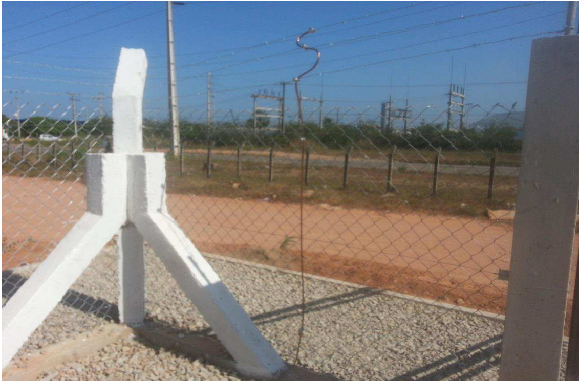
Figura 18 - Detalhe de aterramento da cerca da SE.
