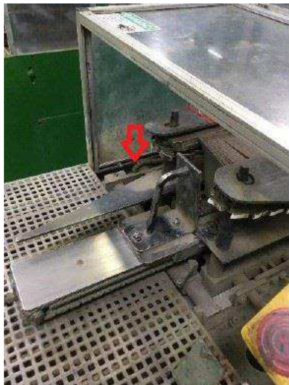
Figura 4 – Aspecto operacional (proteção fixa) da máquina envelopadora linha 11.
