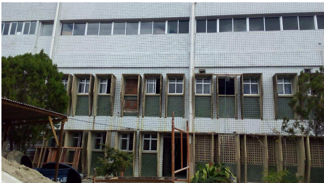
Figura 3 – Vista externa do Bloco CCBS.
