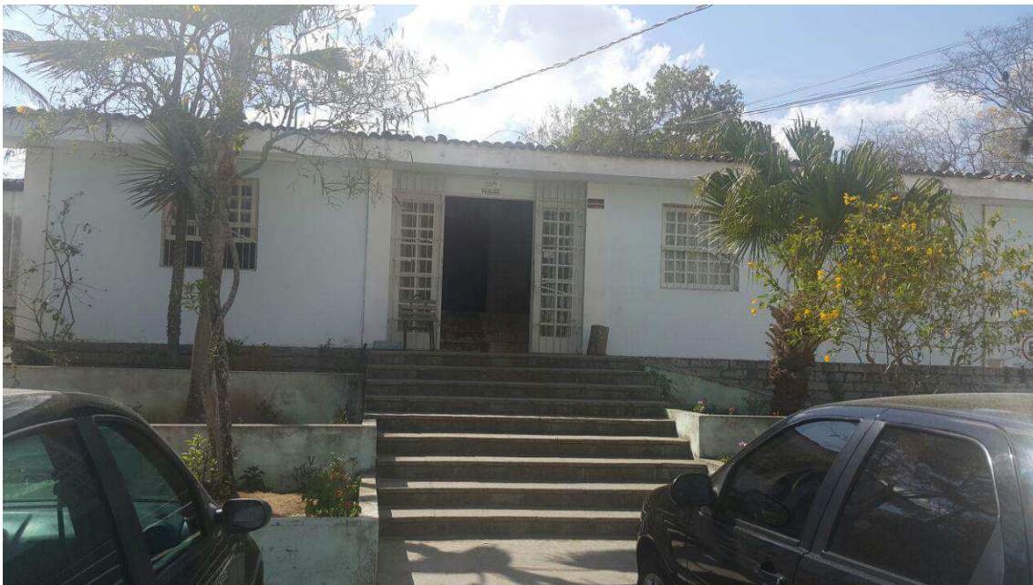
Figura 1 – Setor de engenharia e arquitetura da UEPB.
