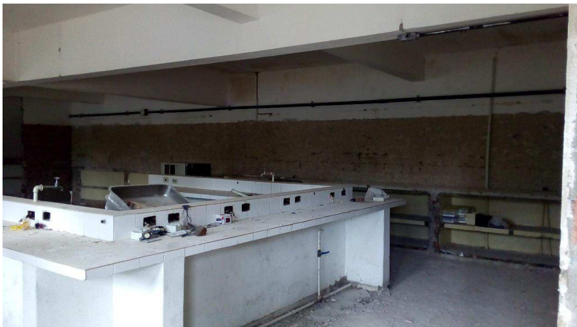
Figura 4 – Sala de laboratório passando por reforma.
