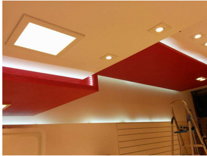
Figura 10: Parte do forro acabado da loja Watt
