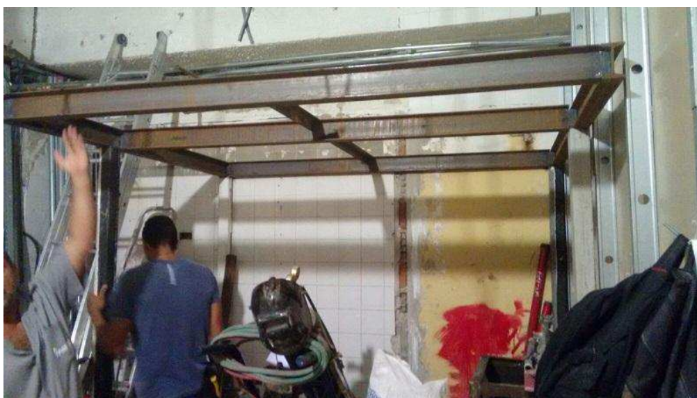
Figura 5: Estrutura para mezanino da loja Watt
