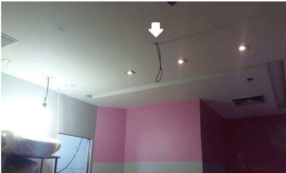
Figura 30: Vista do forro da loja com condutor do circuito de detecção de incêndio indicado pela seta branca
