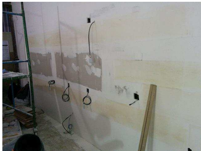
Figura 7: Parede com as placas de drywall fixadas e pontos elétricos previstos
