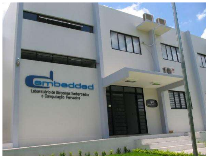
Figura 2.1 - Fotografia da estrutura externa do Embedded
