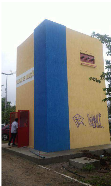
Figura 12. Cubículo de medição do Campus I – Campina Grande.
