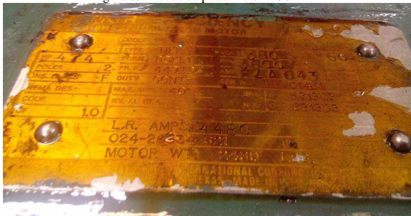
Figura 63: Dados de placa motor TOSHIBA
