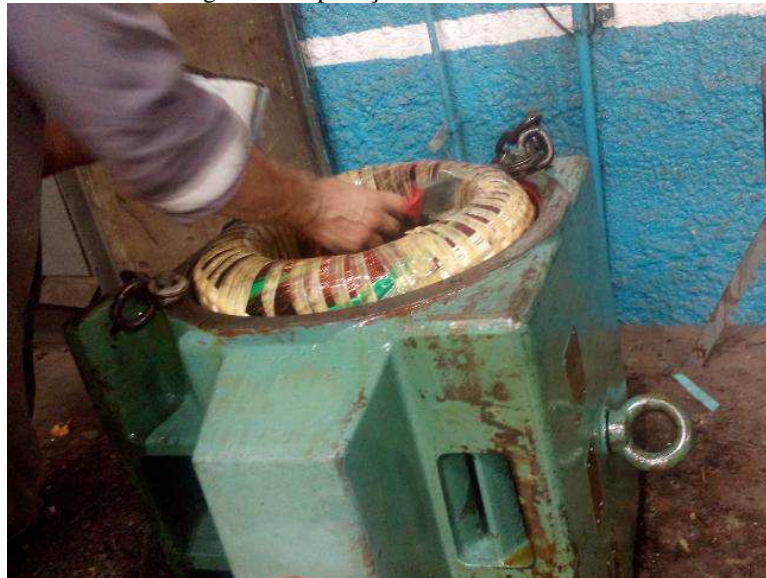
Figura 78: Aplicação de resina isolante
