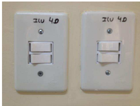
Figura 4.2 - Interruptores após mudança de numerações.
