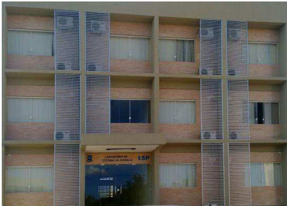
Figura 2.1 – Faixada do Laboratório de Sistemas de Potência.
