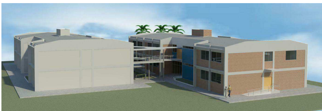
Figura 1. Prédio existente (a esquerda) e prédio a ser projetado (a direita)
