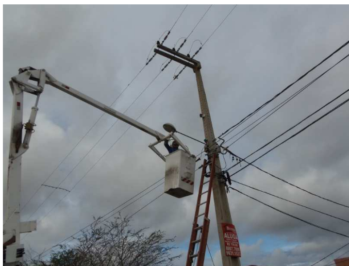
Figura 17 – Poste com braço de pequeno porte .
