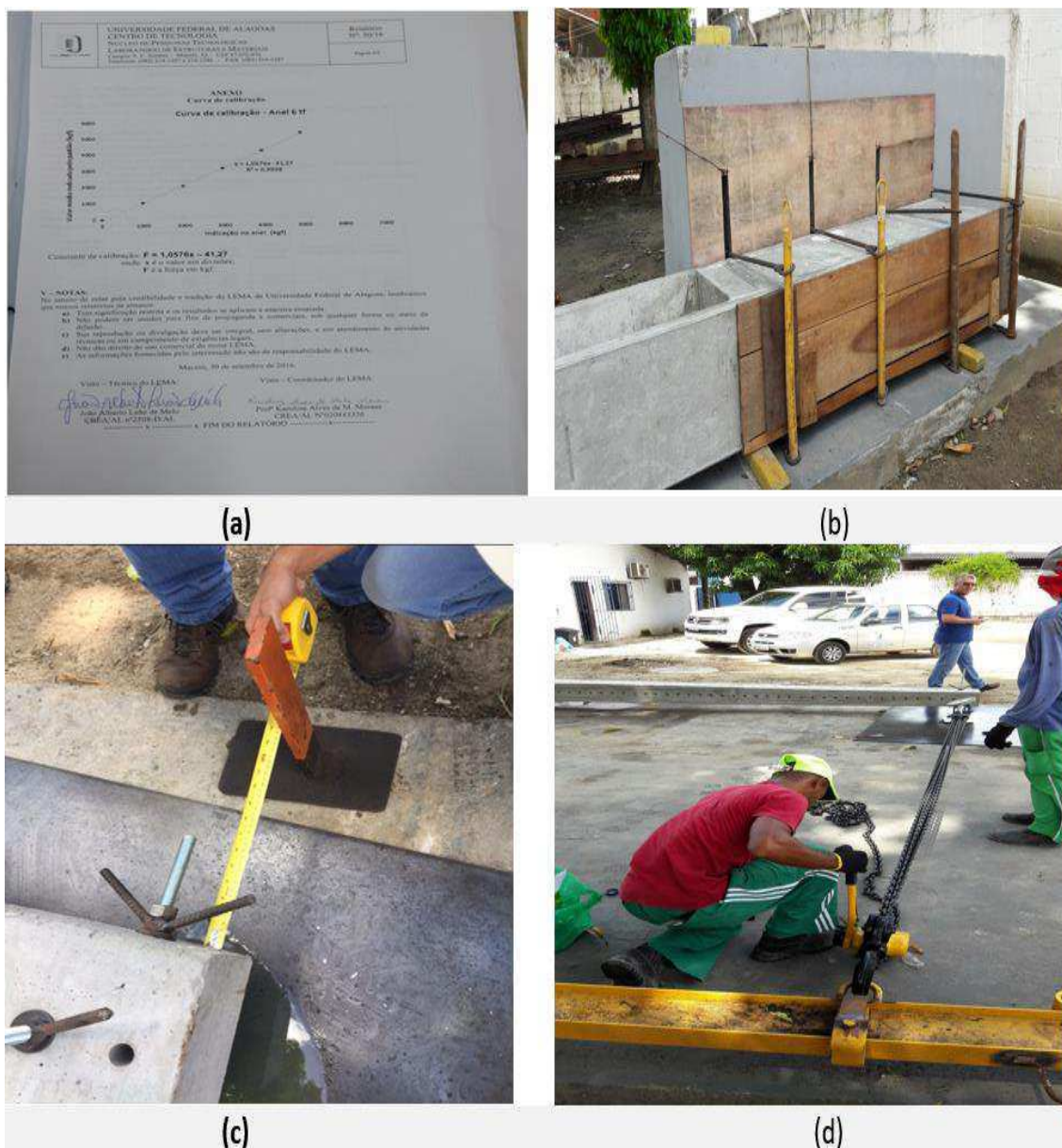
Figura 4: Ensaio em poste de concreto armado.
