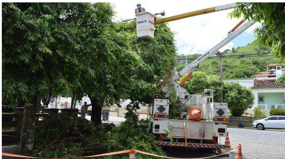
Figura 2.3: Poda de árvore na baixa tensão.
