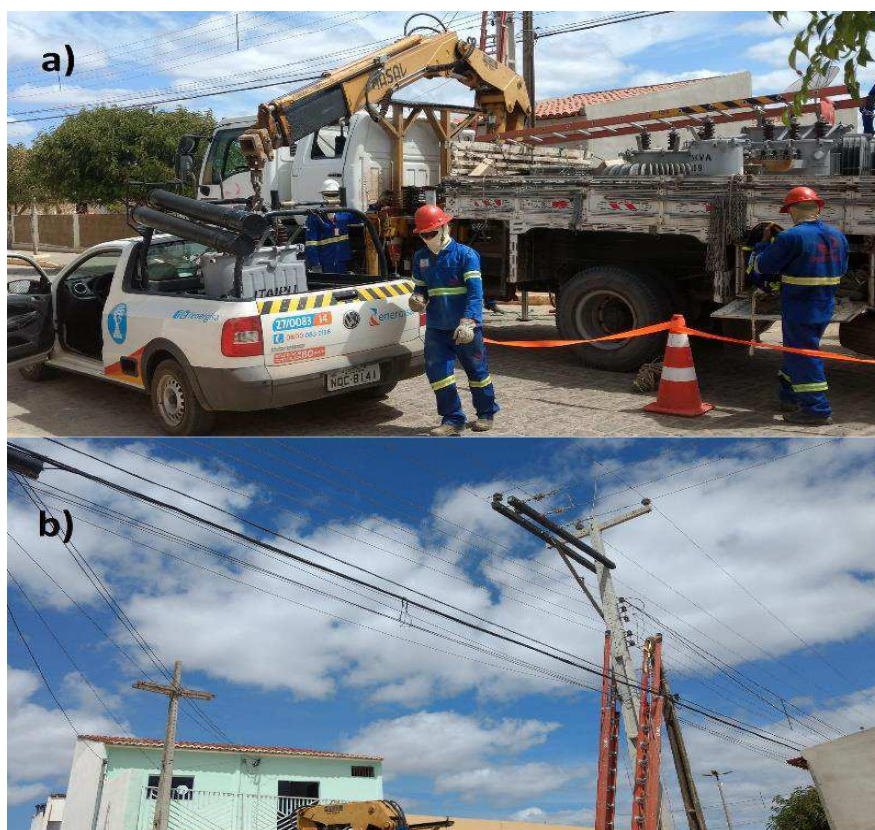
Figura 3.13: Serviços executado em soledade (a- substituição de trafo b- mudança de estrutura da rede).
