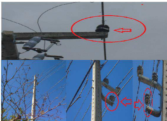
Figura 3.3: Inspeção de alimentador.
