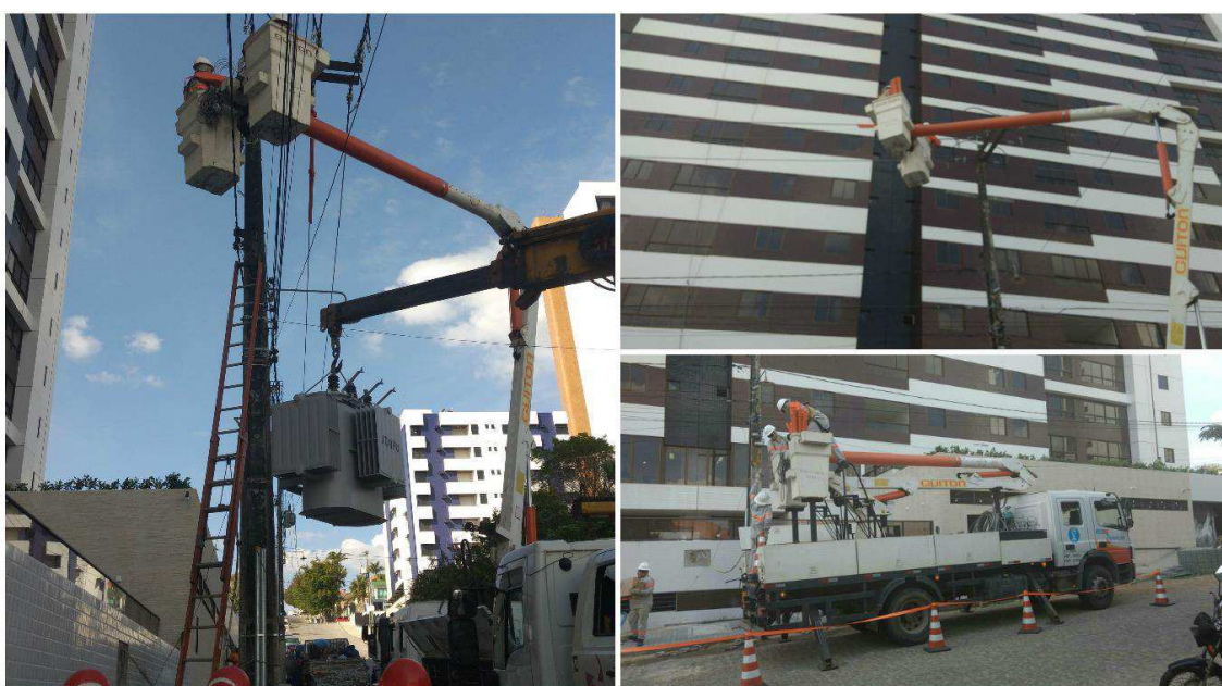
Figura 3.15: Instalação de transformador trifásico de distribuição.
