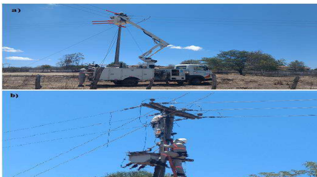
Figura 3.14: Retirada de chave a óleo (a- by pass de média tensão b- retirada da chave).
