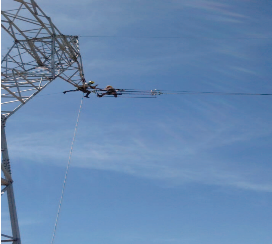
FIGURA 18- ANCORAGEM DE CABOS
