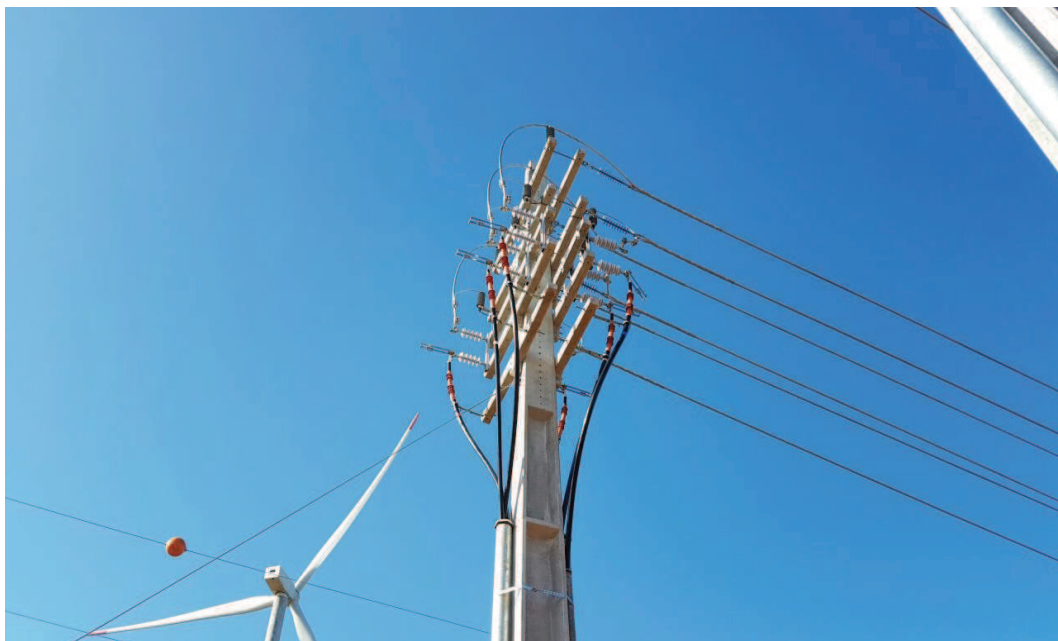
FIGURA 12 –CHAVES SECCIONADORAS E PARA-RAIOS
