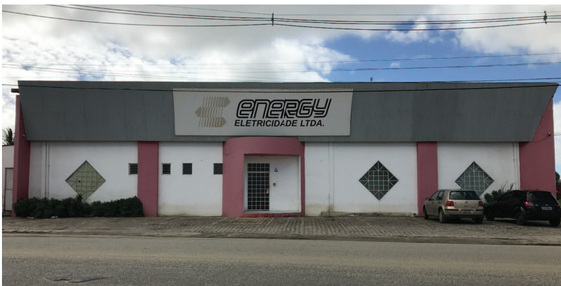
FIGURA 1: FACHADA DA EMPRESA ENERGY ELETRICIDADE
