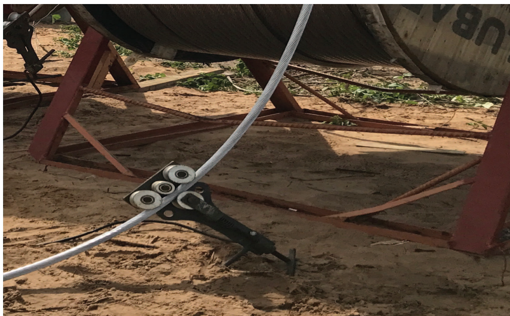
FIGURA 9- ATERRAMENTO DESLIZANTE
