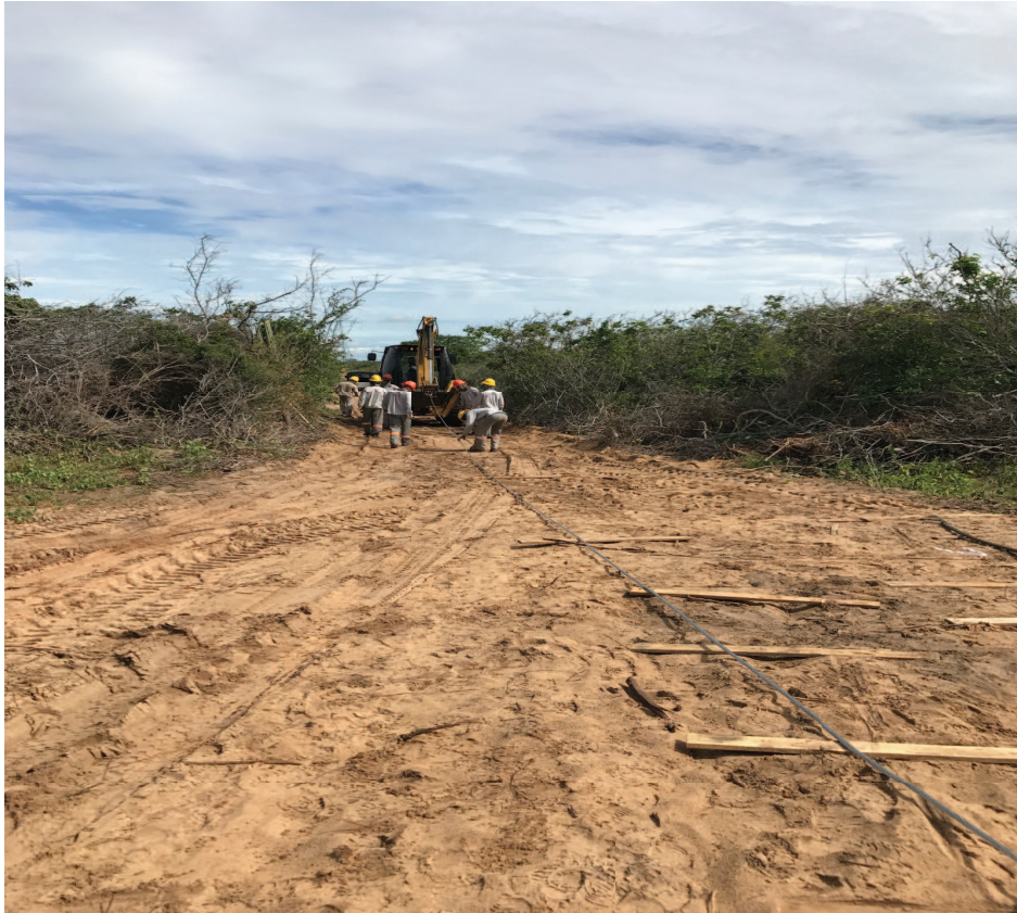
FIGURA 15-LAMENTO DE CABOS
