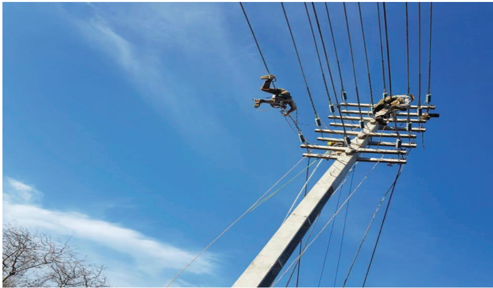
FIGURA 11-ANCORAGEM DOS CABOS À ESTRUTURA ATRAVÉS DE ALÇAS
