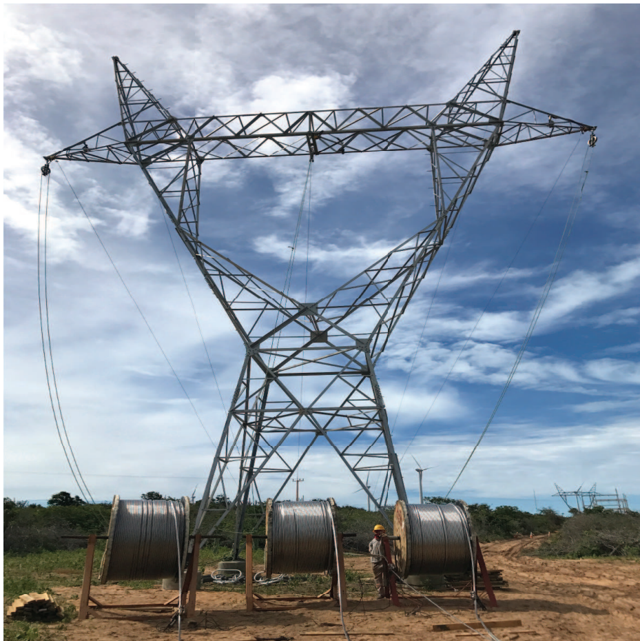
FIGURA 14- POSICIONAMENTO DAS BOBINAS
