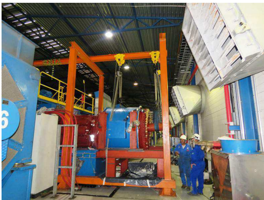
Figura 7.1 – Rotor Extraído - UTCG
