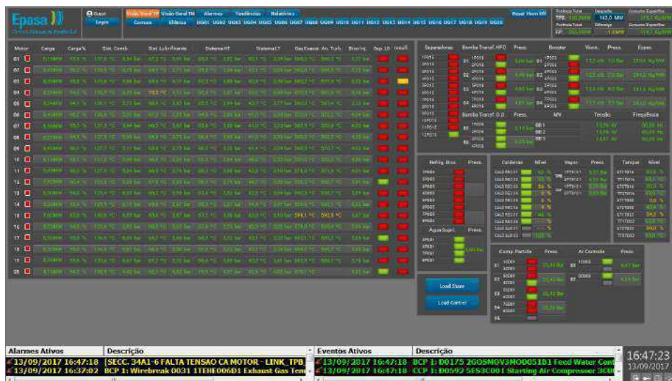
Figura 6.10 – Tela de Visão Geral da Usina - Elipse E3
