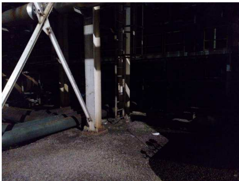
Figura 6.20 – Ponto sem iluminação 1 - Antes da execução do trabalho
