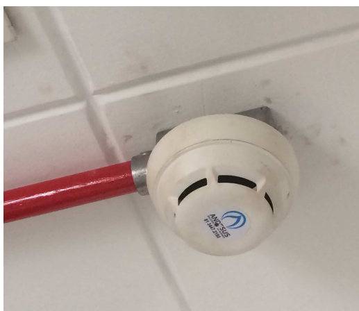
Figure 12 - Detalhe do Detector Óptico de Fumaça Siemens
