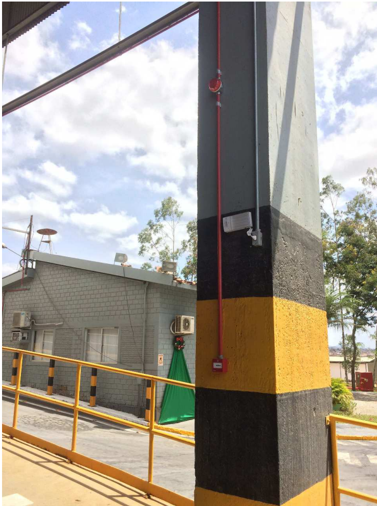
Figure 10 - Montagem de Acionador Manual e Avisador Audio-visual Siemens
