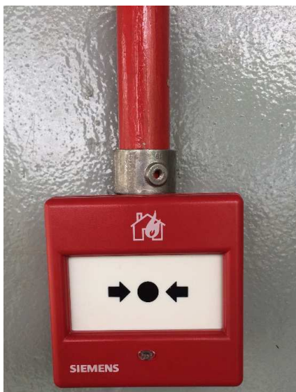
Figure 11 - Detalhe do Acionador Manual Siemens
