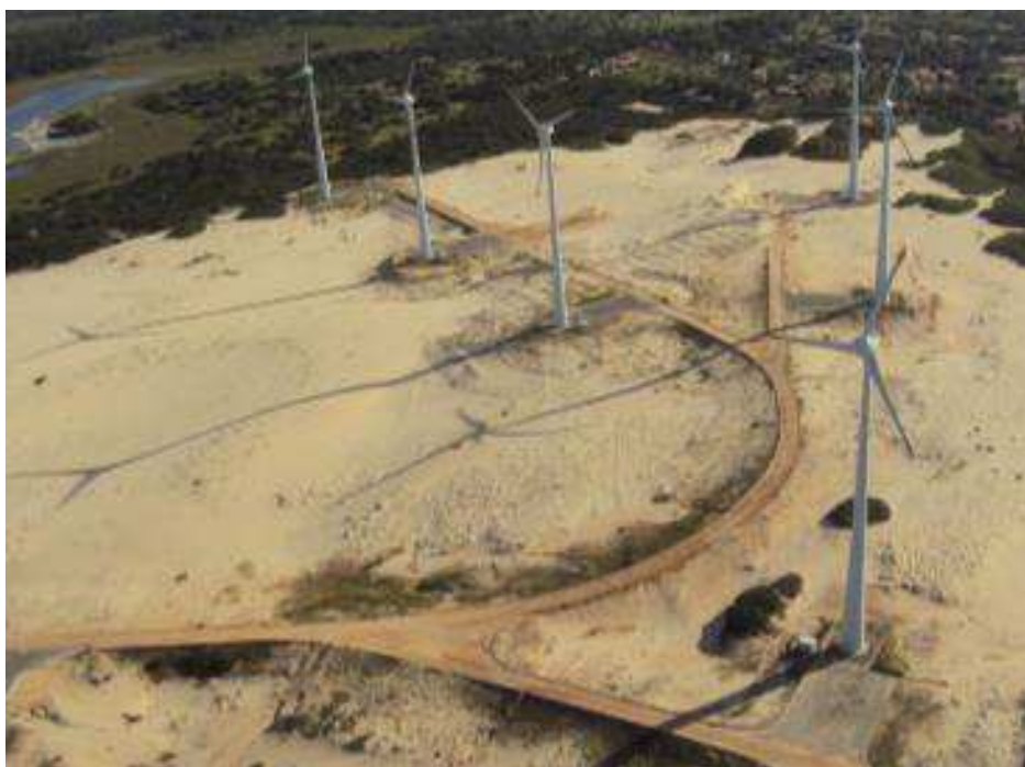
Figura 2 - Usina eólica de propriedade da CPFL Renováveis
