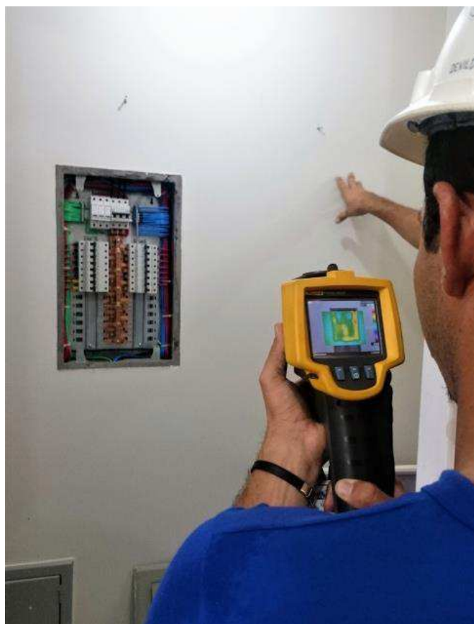
FIGURA 11 – Ensaio de termovisão realizado no quadro de distribuição da residência periciada
