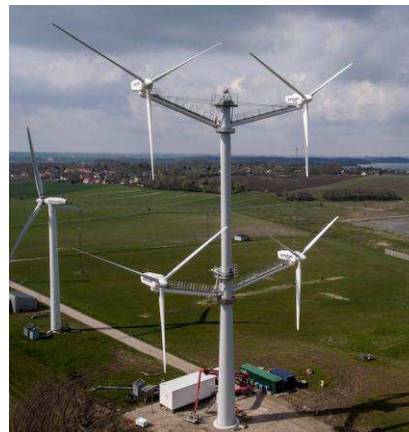
FIGURA 5: AEROGERADOR VESTAS MULTI ROTOR
