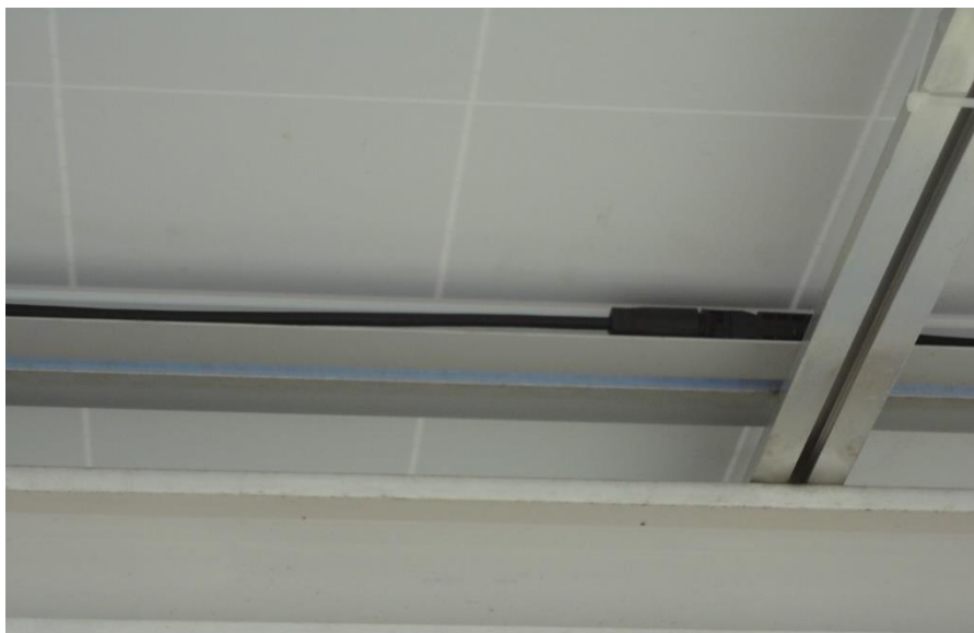
Fig. 27 Foto Conector tipo MC4
