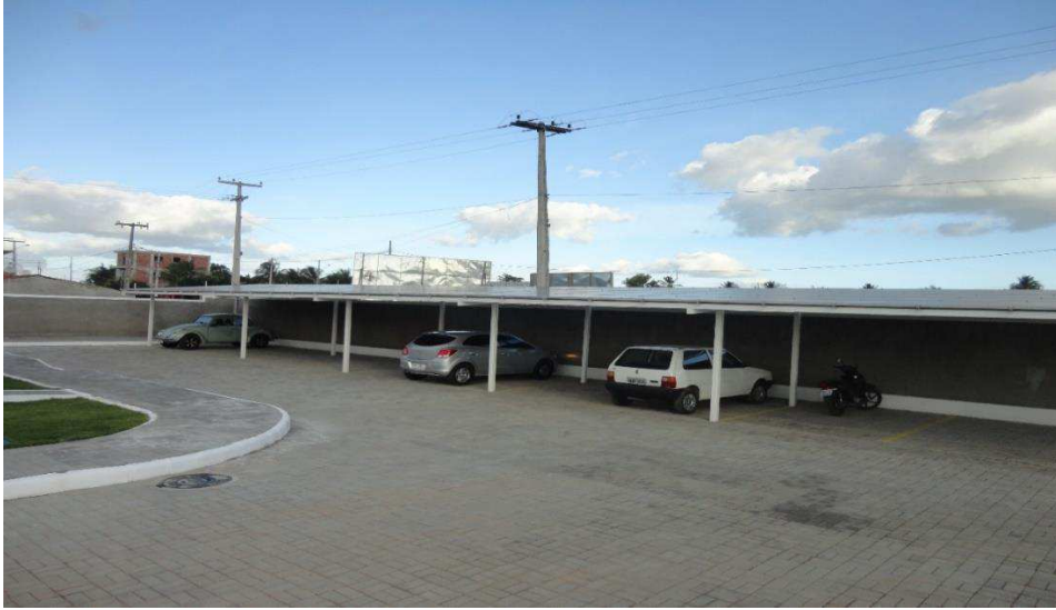
Fig. 23 Foto Painéis Fotovoltaico
