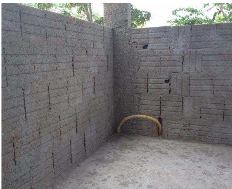
Figura 10: Guarita do bloco Educação Física.
