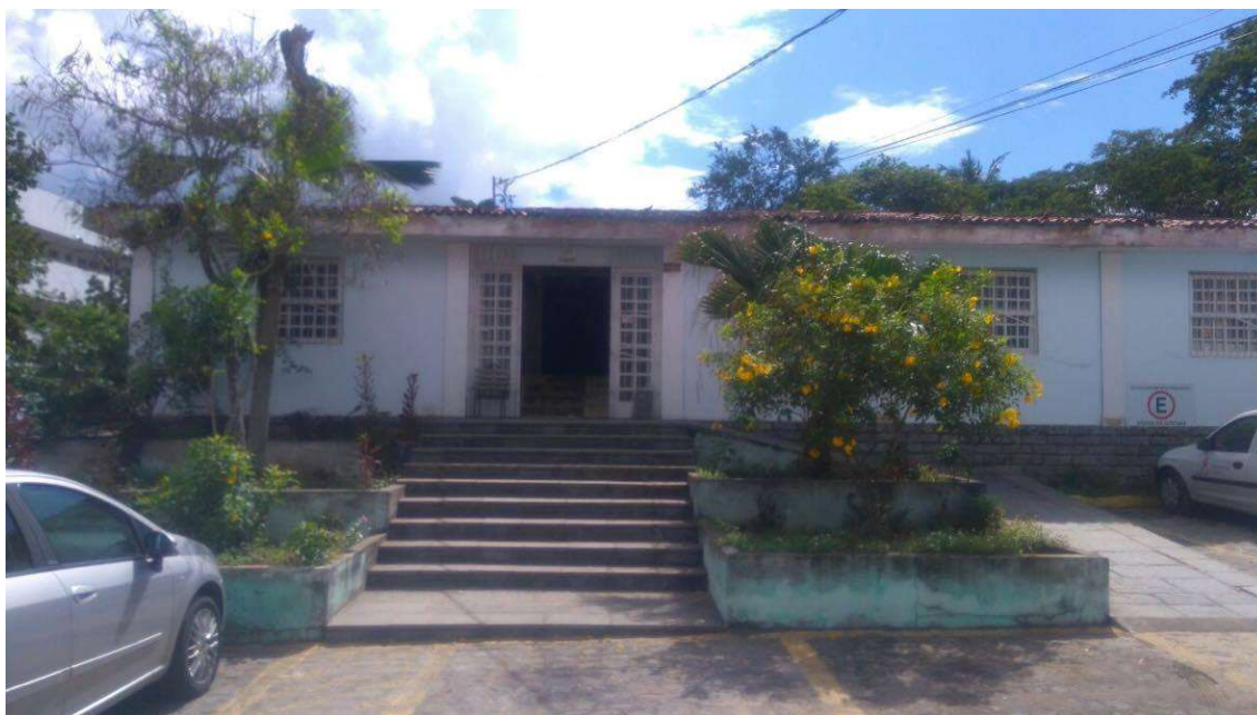
Figura 2 - Vista frontal do prédio da Pró-Reitoria de Infraestrutura.
