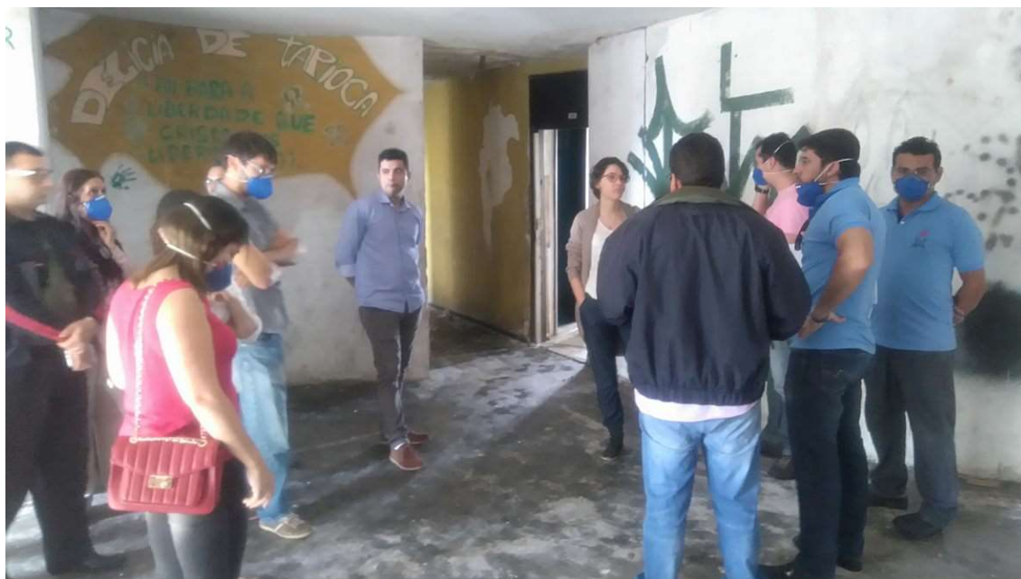
Figura 5 - Equipe da UEPB durante visita técnica realizada ao novo prédio em 20/07/2017.
