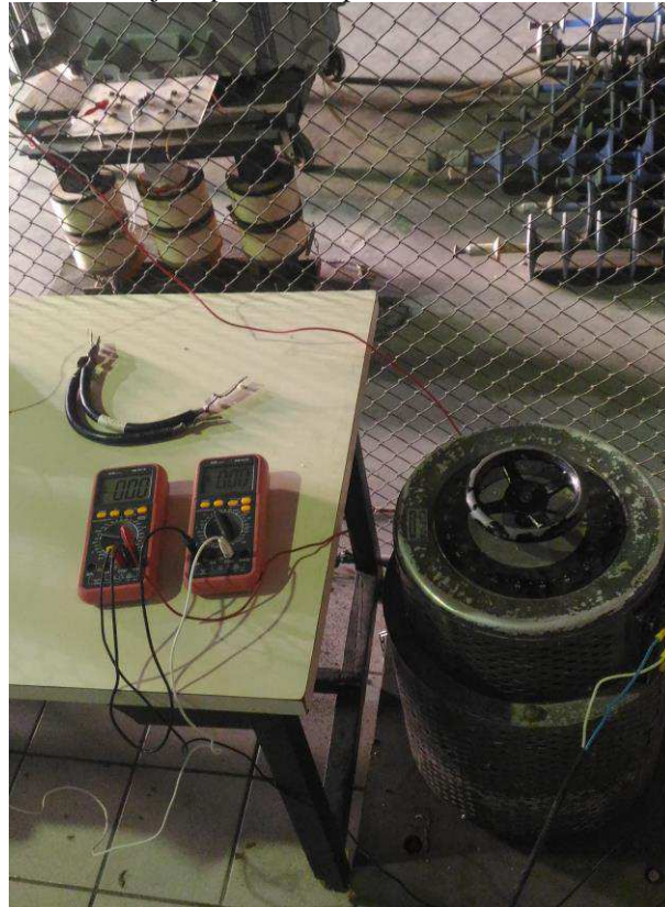
Figura 14. Arranjo experimental para testes com o transformador.
