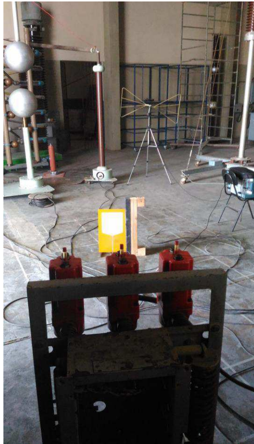
Figura 12. Antenas posicionadas para captação de sinais eletromagnéticos.
