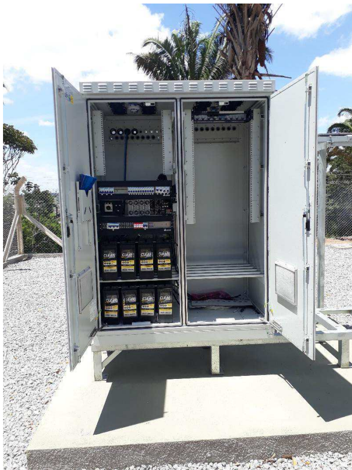
Figura 13 - Gabinete aberto após instalação
