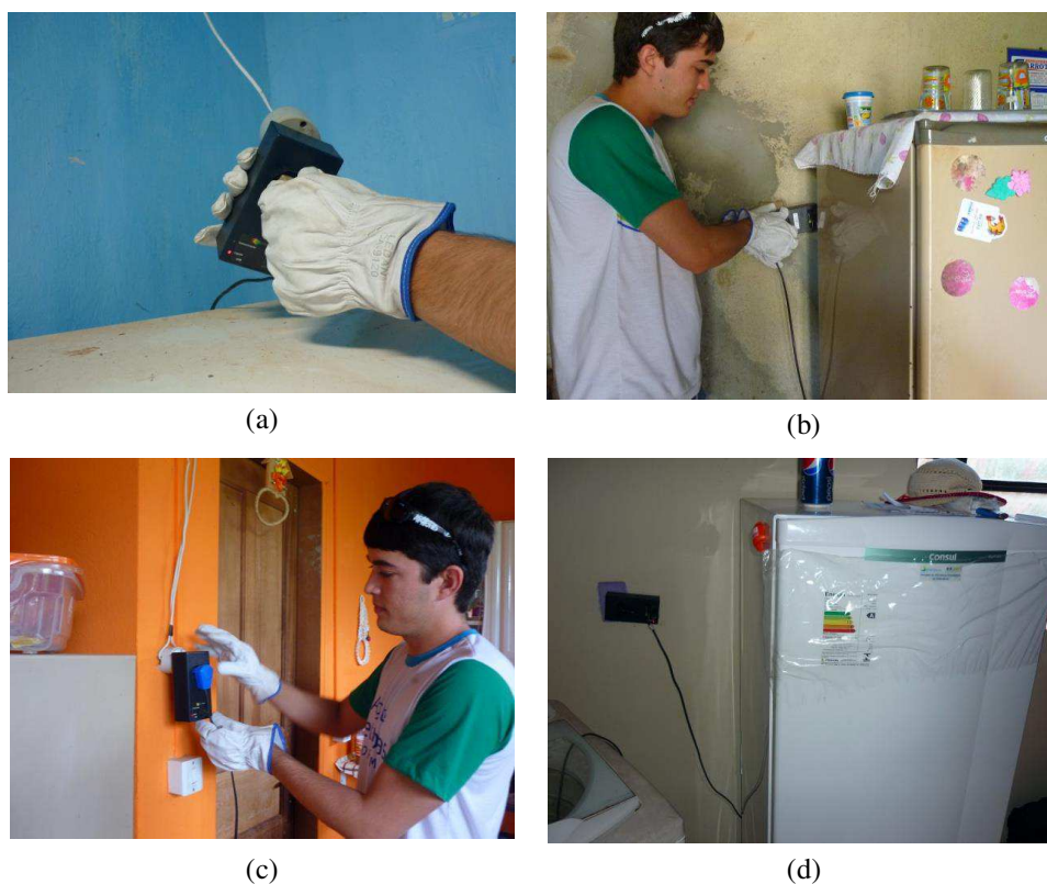
Figura 8- Instalação de medidor por agente de campo em residência contemplada.
