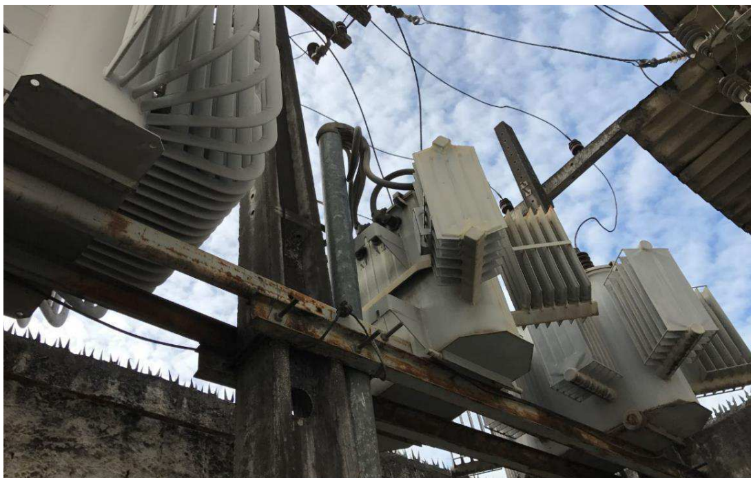
Figura 10: Subestação aérea.
