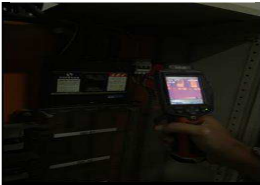
Figura 13: Utilização do termovisor para determinar pontos quentes.
