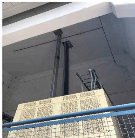
Figura 19 – Selar abertura com Firestop na parede da passagem de cabos do Porão de Cabos dos TGs
