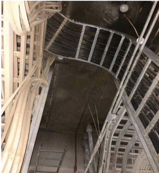
Figura 21 – Revestimento com cablecoating da prumada de cabos verticais no porão de cabos dos TGs
