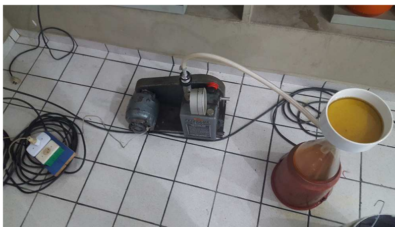
Figura 17 – Motor utilizado para filtrar o óleo isolante.
