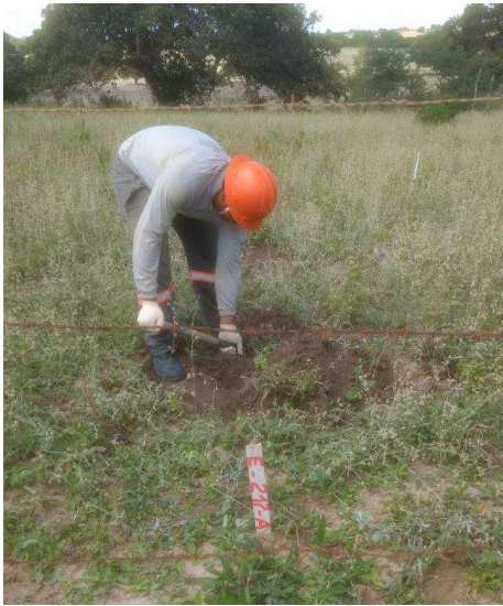
Figura 24. Atividade escavação manual.
