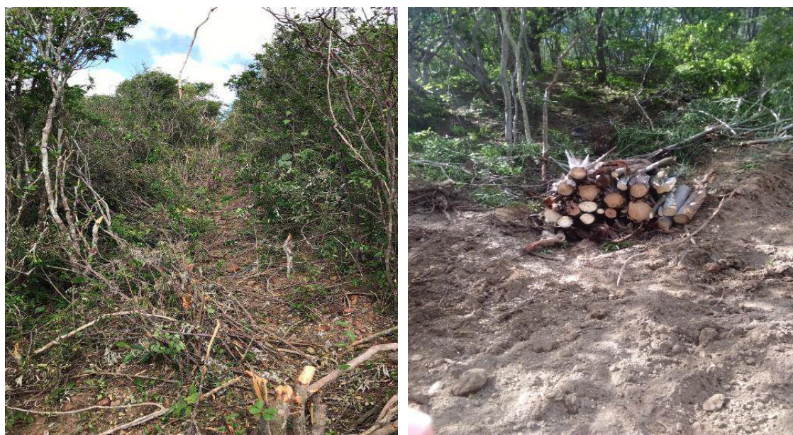
Figura 22. Atividade de supressão vegetal e cubagem de madeira.
