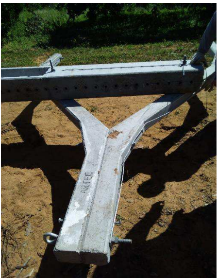
Figura 31. Aparelhamento de estrutura tipo suspensão.
