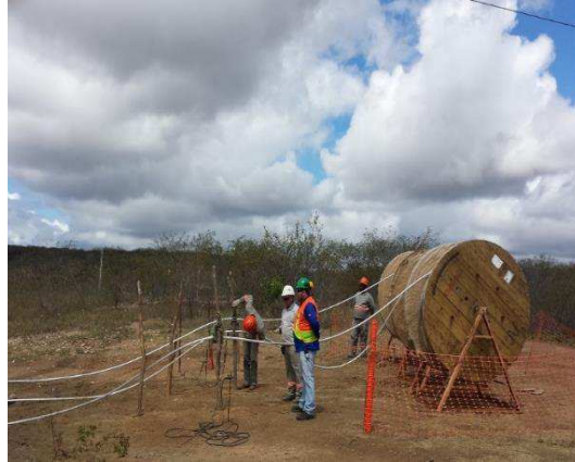
Figura 33. Praça de lançamento de cabos.
