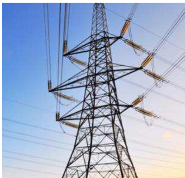
Figura 8. Estrutura tipo ângulo.
