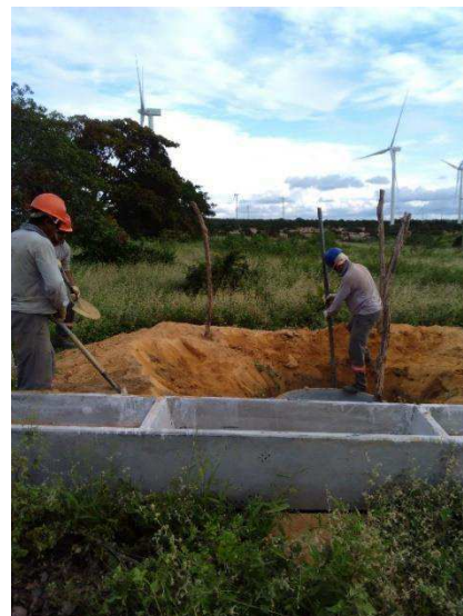
Figura 28. Transporte e inserção do tubulão no solo.
