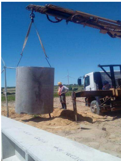
Figura 28. Transporte e inserção do tubulão no solo.
