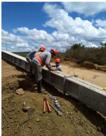
Figura 30. Aparelhamento de estrutura tipo ancoragem.
