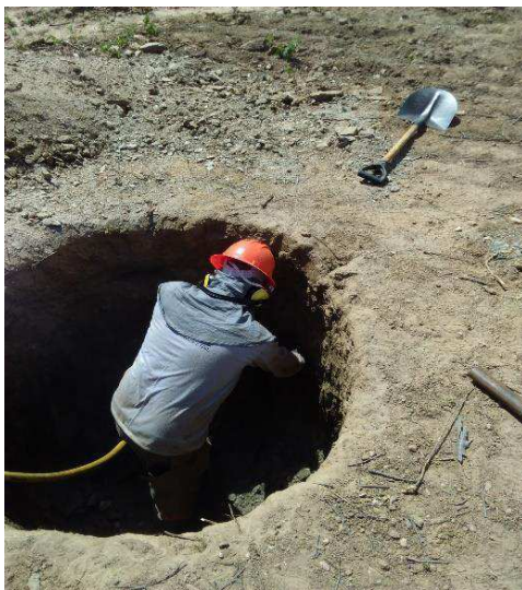
Figura 25. Atividade de escavação com uso de rompedor acoplado no compressor e na escavadeira hidráulica.
