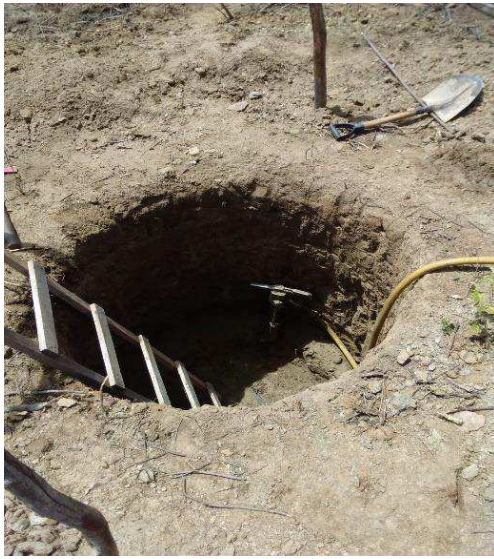
Figura 27. Fundação tipo plantio de poste, com presença de rocha.
