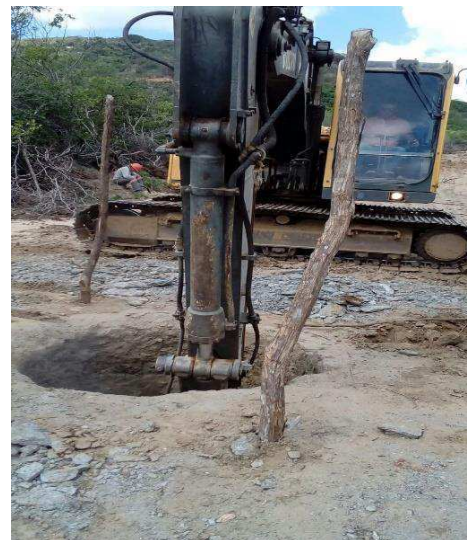
Figura 25. Atividade de escavação com uso de rompedor acoplado no compressor e na escavadeira hidráulica.
