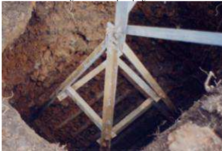
Figura 13. Fundação tipo grelha.
