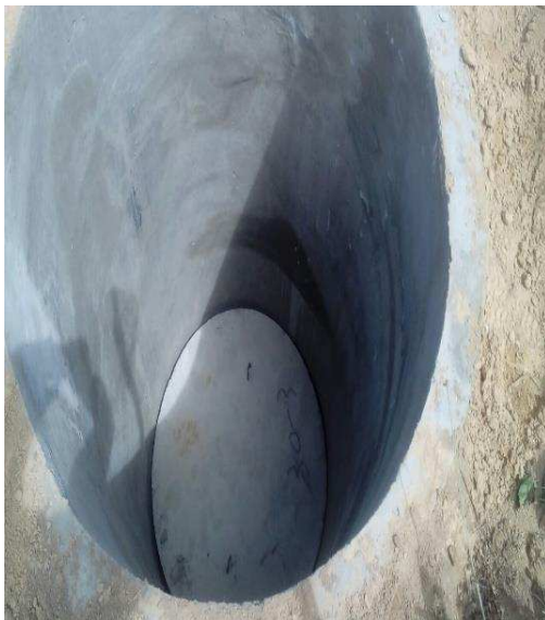
Figura 26. Fundação tipo plantio tubulão, sem presença de rocha.
