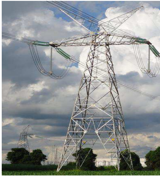
Figura 6. Estrutura tipo ancoragem
