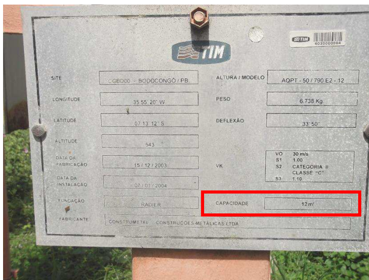
Figura 2 - Placa da torre do site NLCGBD00 com destaque para a indicação da carga máxima suportada (Fonte: SAVENGE Engenharia LTDA)
