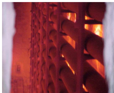
Figura 2.6: Serpentinhas da Zona de radiação
