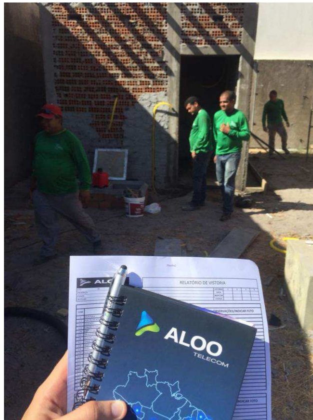
Figura 8: Construção da parte civil da estação
