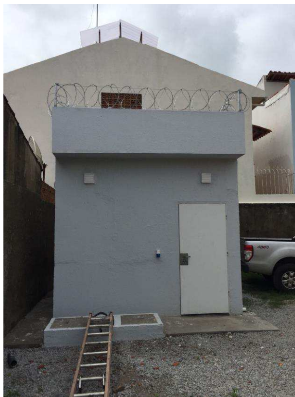
Figura 9: Estrutura civil finalizada
