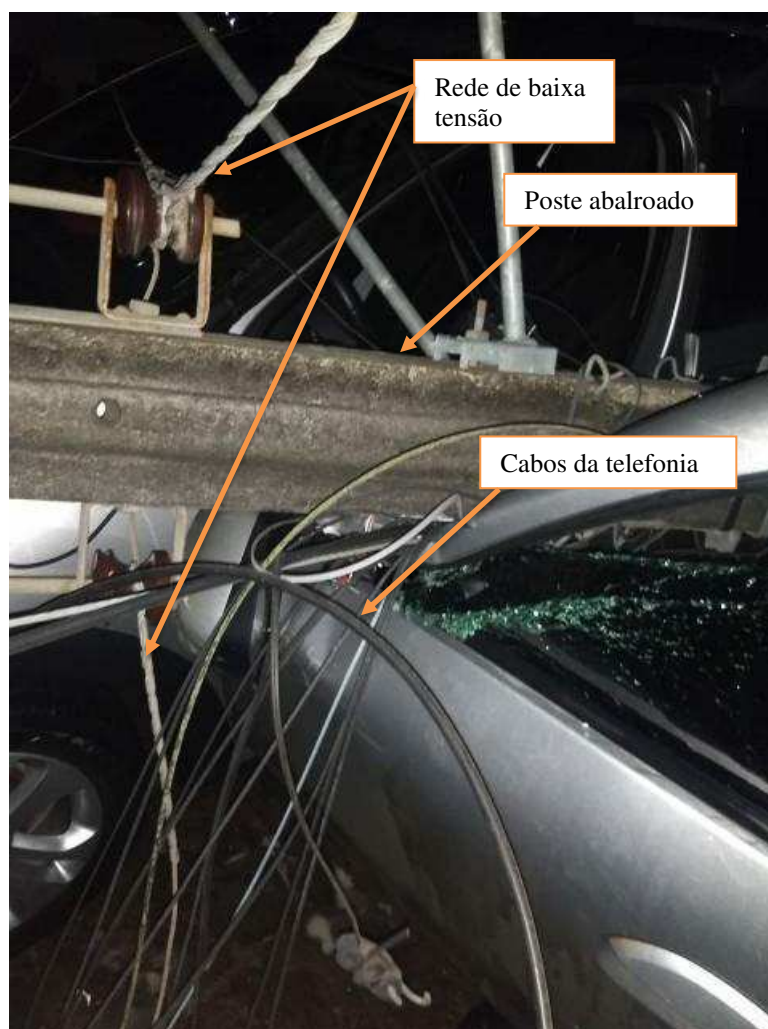
Figura 9 - Abalroamento de poste
