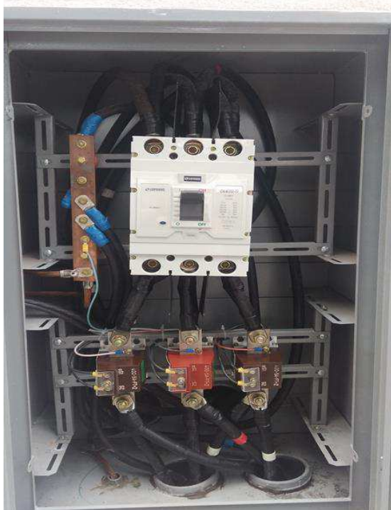
Figura 8- Disjuntor termomagnético caixa moldada
