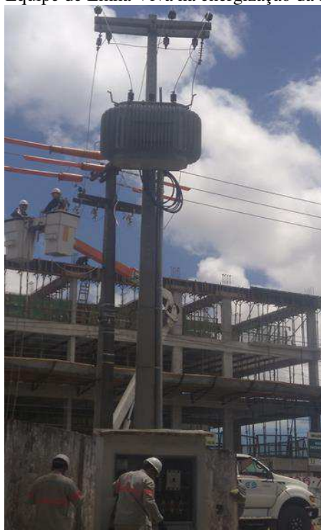
Figura 7- Equipe de Linha Viva na energização da subestação
