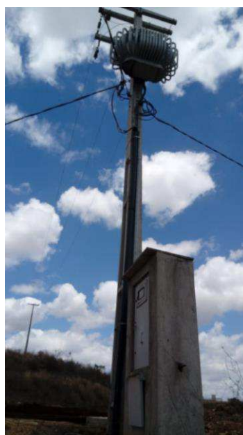
Figura 16: Subestação aérea.
