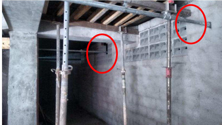
Figura 11: Tubulação de incêndio - Subestação comercial.
