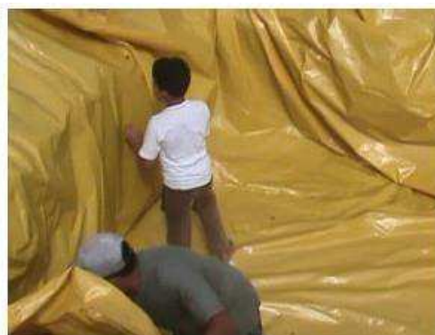
b) Impermeabilização da bacia
