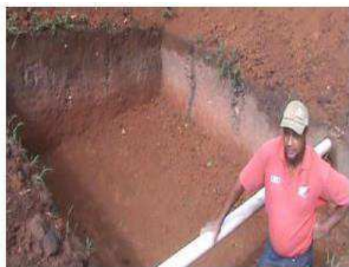
a) Escavação da trincheira
