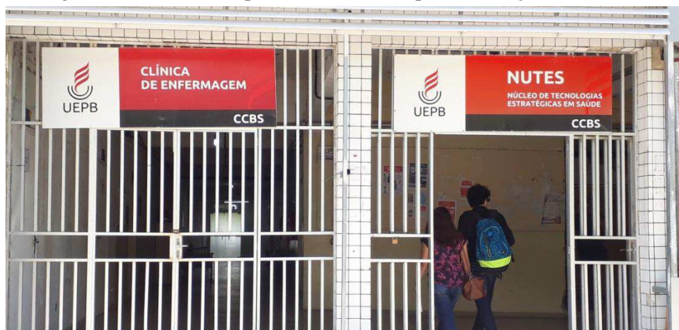
Figura 8: Local de acompanhamento de obra para elaboração do As built .
