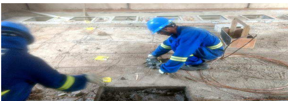
Execução da malha de terra da casa de comando da SE Imbiribeira quando da soldagem dos cabos de aterramento.
