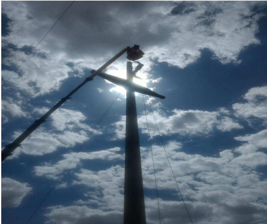
Figura 16: Montagem de cruzeta de concreto em estrutura
