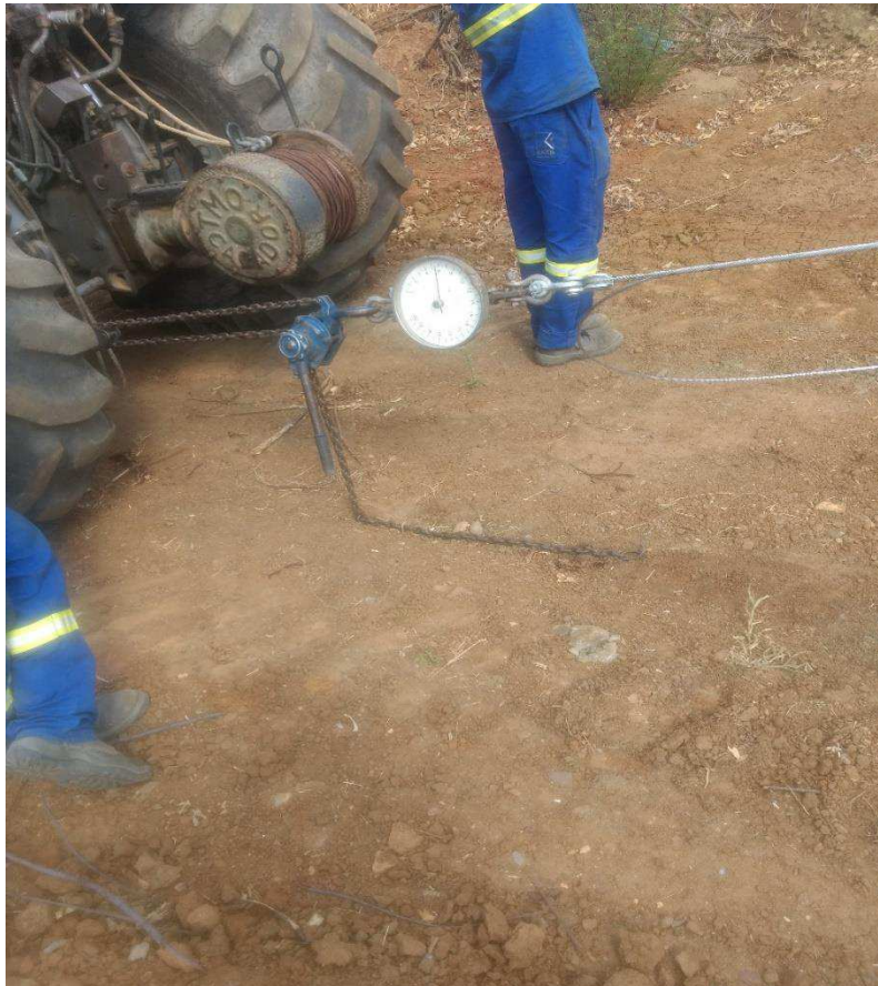
Figura 17: Nivelamento dos cabos feito com trator e Dinamômetro
