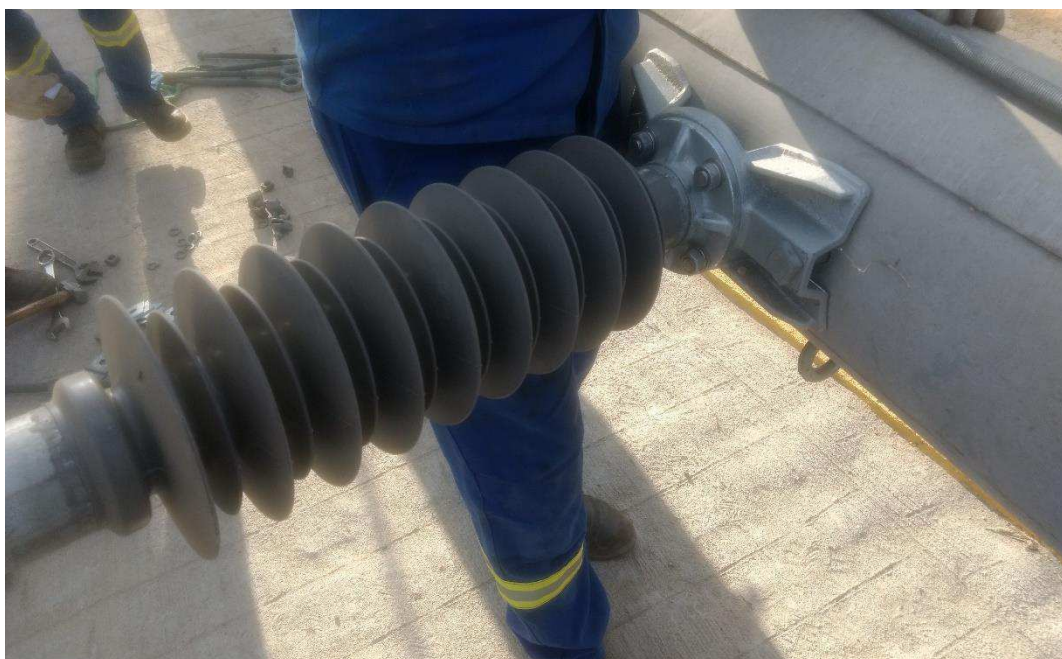
Figura 14: Montagem de isolador line post (detalhe)
