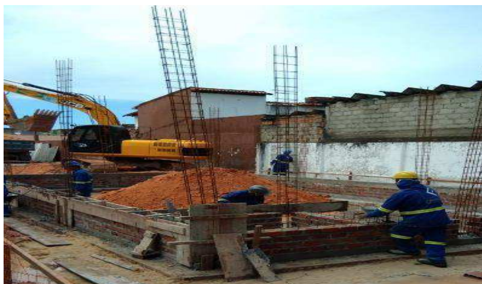
Figura 8: Execução de alicerce da casa de comando
