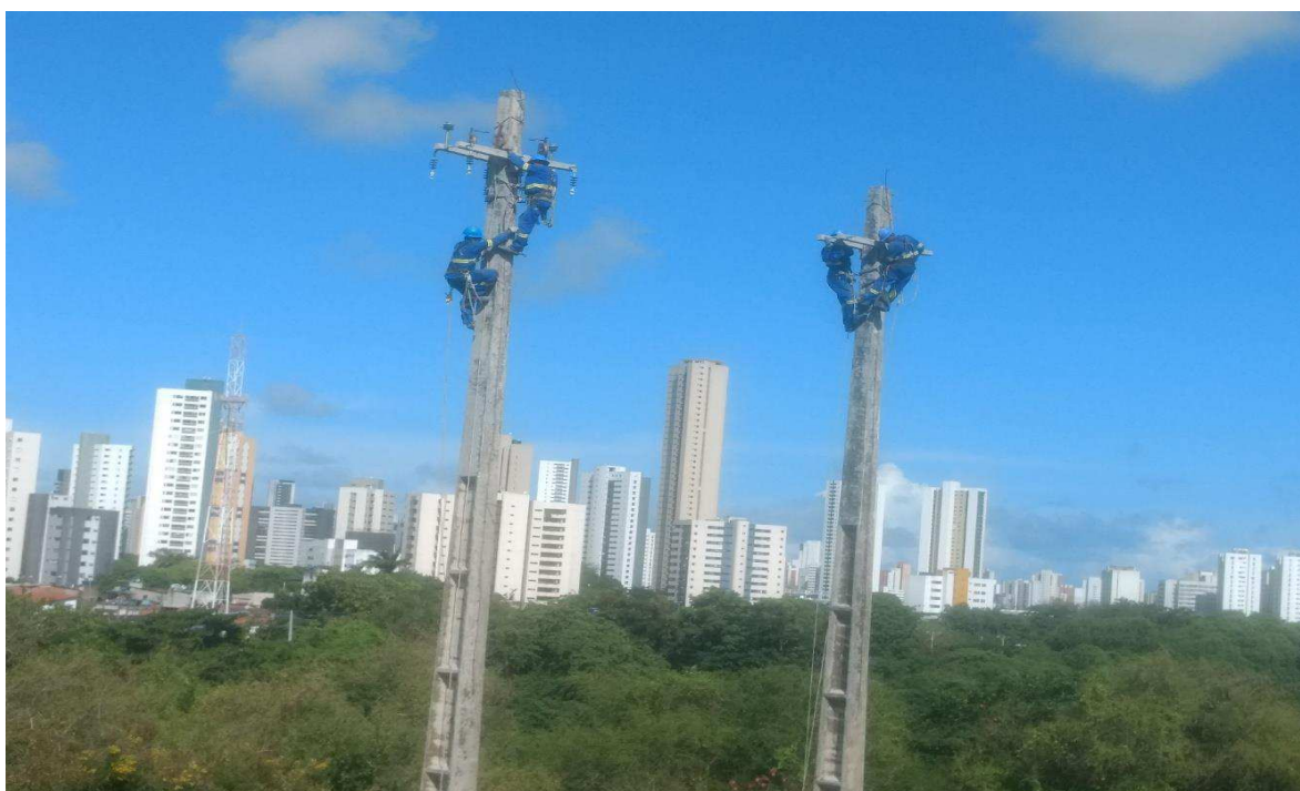
Figura 24: Detalhe da atividade dos montadores das estruturas
