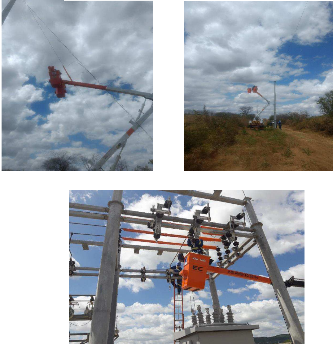
Figura 15: Acesso aos trechos energizados por meio de caminhão isolado NR-12
