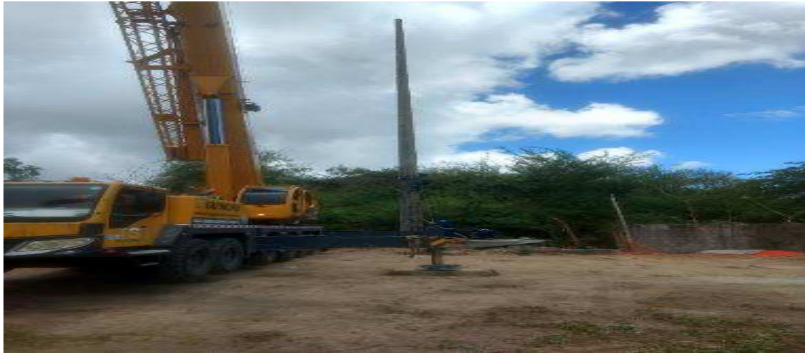
Figura 19: Implantação dos postes para a travessia do alimentador 01Z6- Rio Capibaribe
