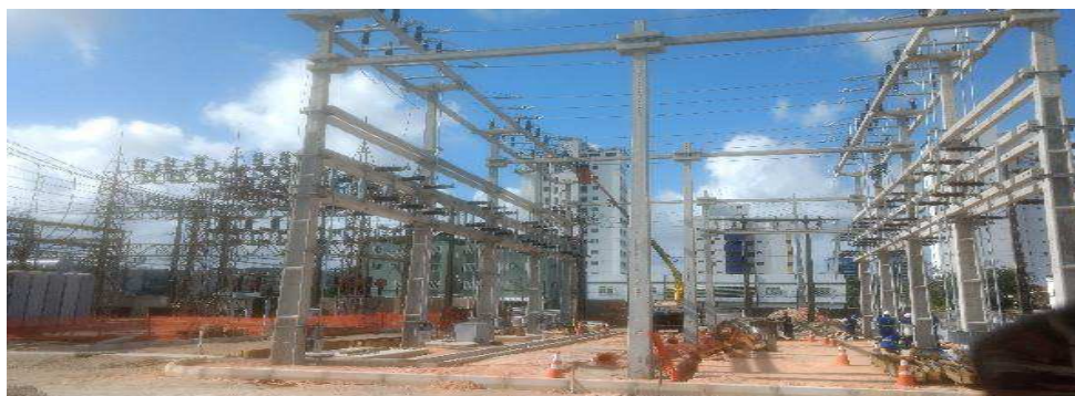
Fase inicial da construção do barramento de 69kV na SE Imbiribeira
