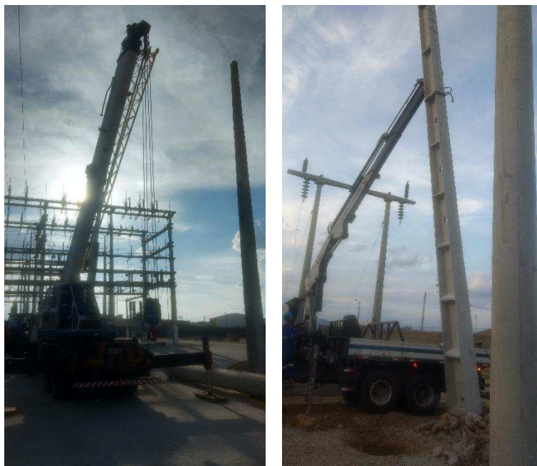
Figura 13: Implantação de postes com uso de guindaste
