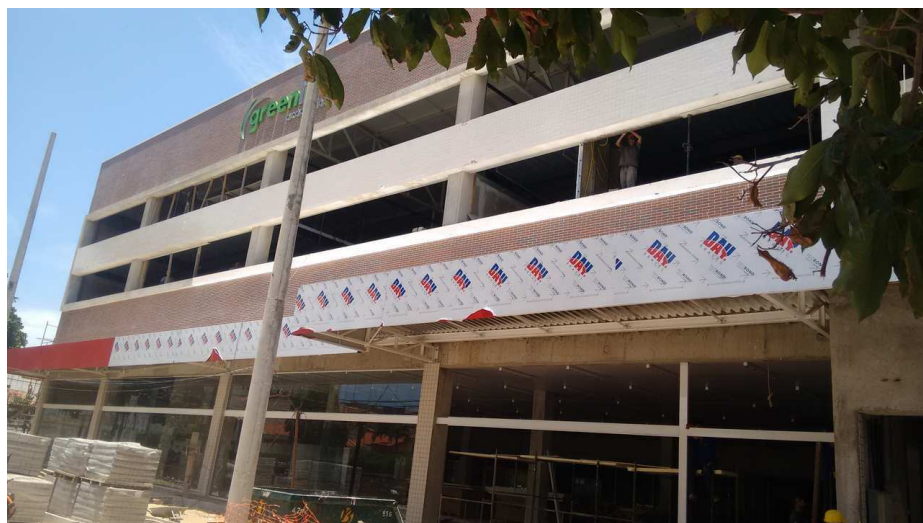
Figura 5 – Fachada do prédio em construção.
