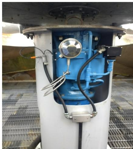
Figura 19: Instalação do sensor VSA001
