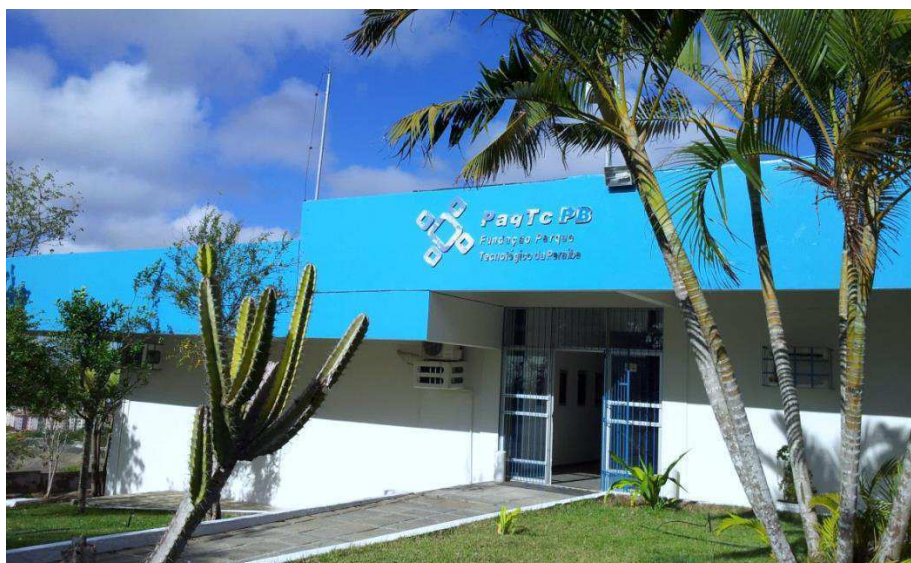
Figura 1 - Fundação Parque Tecnológico da Paraíba, Campina Grande, PB.
