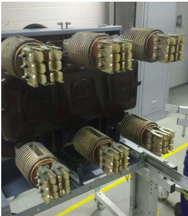
Figura 15 - Disjuntor do barramento removido.
