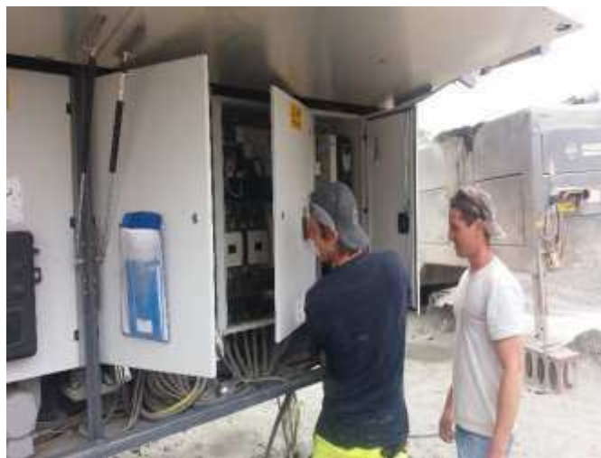
Figura 43 - Fotografia dos engenheiros realizando a ligação das máquinas com a SE.
