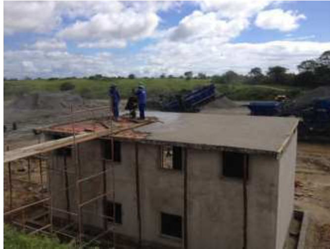
Figura 28 - Fotografia da laje da SE.
