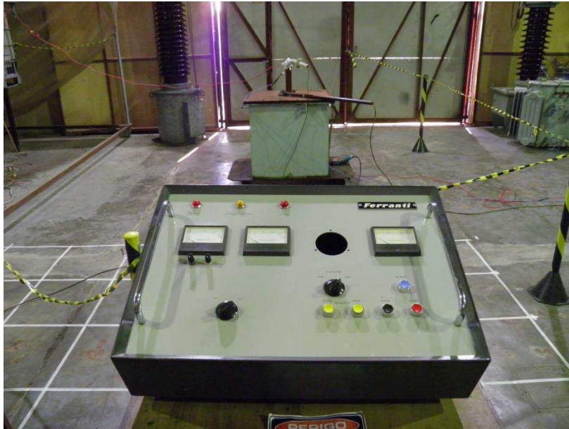
Figura 26 – Mesa de controle, transformador e ponta de prova utilizada no ensaio.
