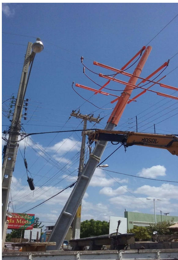
Figura 10: Implantação do poste circular 12/1200.
