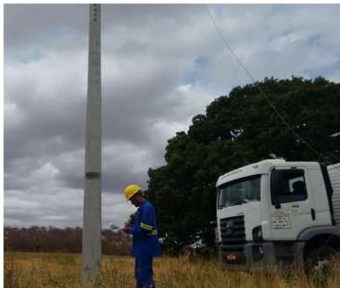
Figura 11: Georreferenciamento de uma estrutura.
