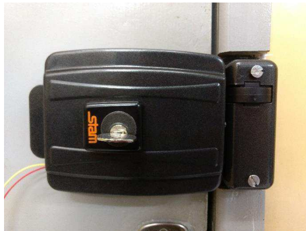
Figura 12: Fechadura elétrica readequada para que fosse possível abrir por dentro.
