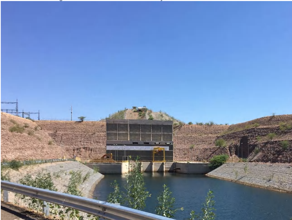
Figura 5: Visão externa frontal da Estação de Bombeamento 1 do eixo Leste
