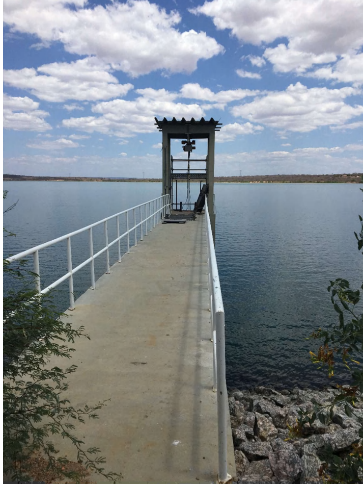
Figura 15: Entrada da TUD do reservatório Areias
