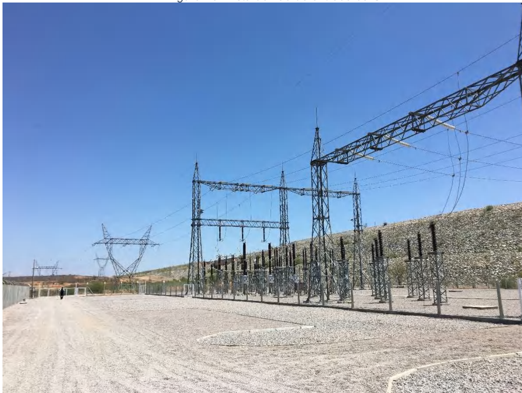
Figura 10: Vista do vão de entrada da SE-E1
