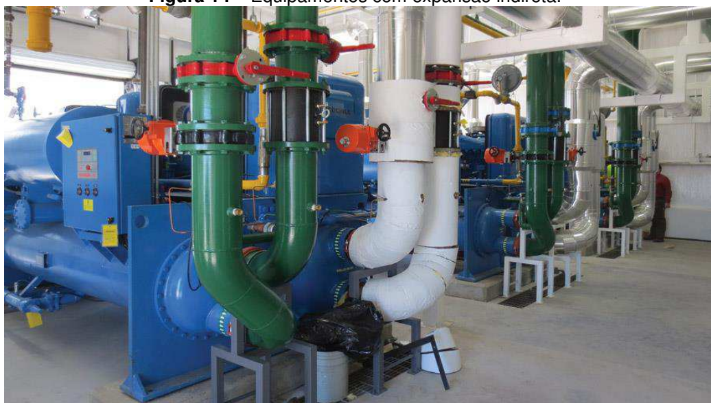
Figura 14 – Equipamentos com expansão indireta.
