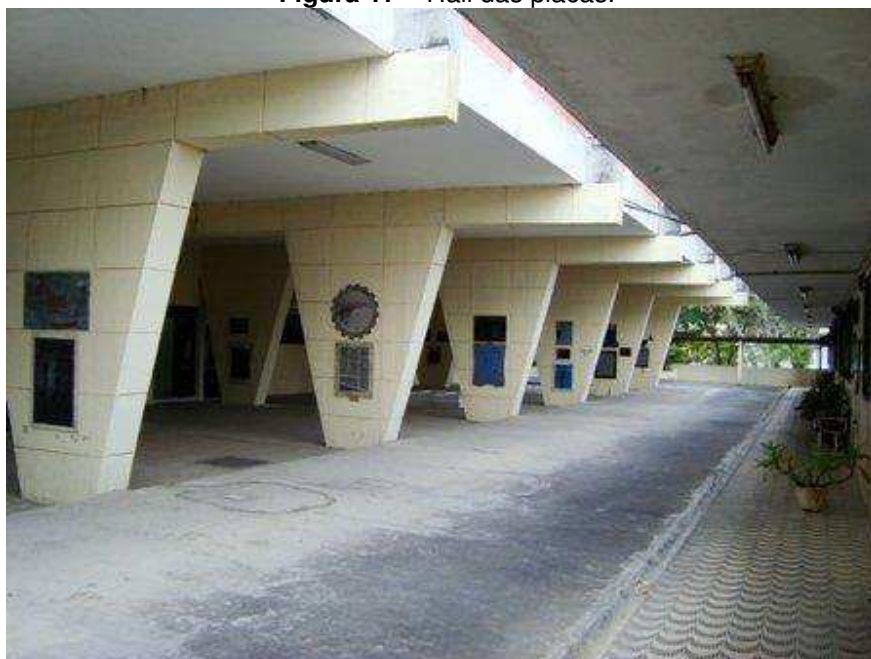
Figura 17 – Hall das placas.
