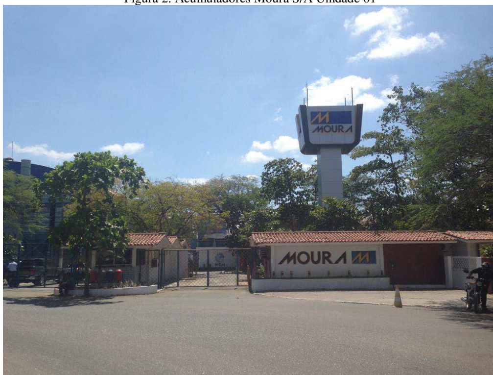
Figura 2. Acumuladores Moura S/A Unidade 01
