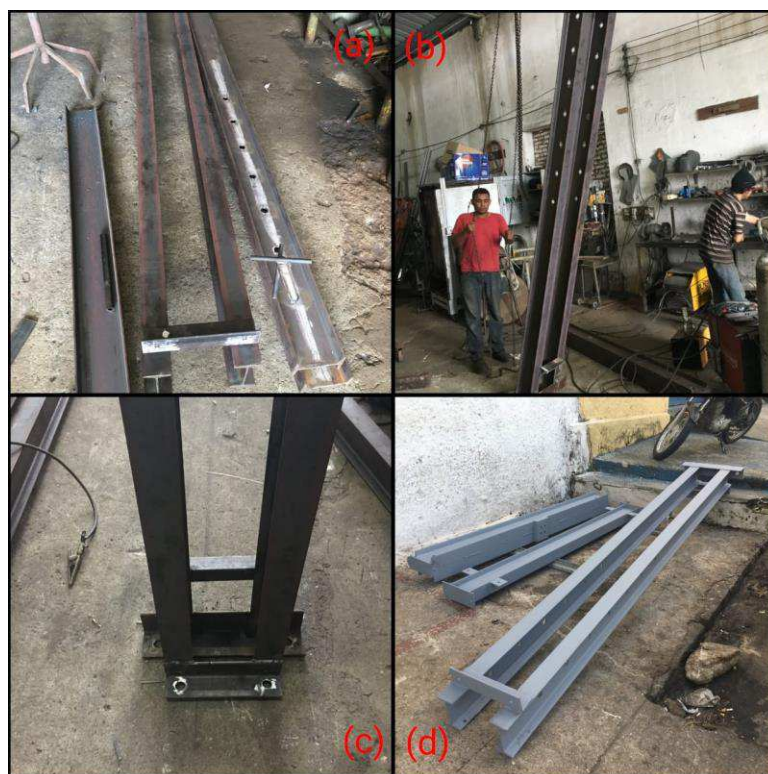
Figura 31 - (a) - Montagem dos perfis metálicos; (b) – Solda e montagem de laterais do pórtico metálico; (c) – Furos na base da estrutura para fixação dos chumbadores; (d) - Processo de secagem das peças após aplicação do primer.
