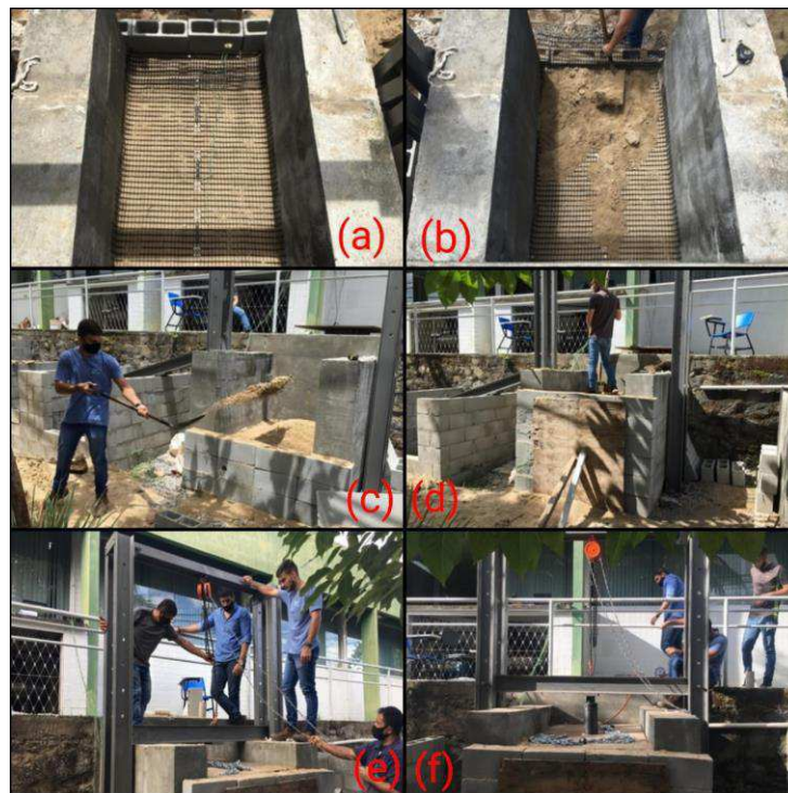
Figura 46 - (a) - Camada de geogrelha posicionada no modelo físico instrumentado; (b) - Material de enchimento é depositado suavemente sobre os sensores; (c) - Lançamento do material de enchimento em pontos onde não havia contato direto do solo lançado com os sensores; (d) – compactação da última camada de solo; (e) – lançamento da vida de reação; (f) – Posicionamento do macaco hidráulico sobre o centro da chapa de aço
