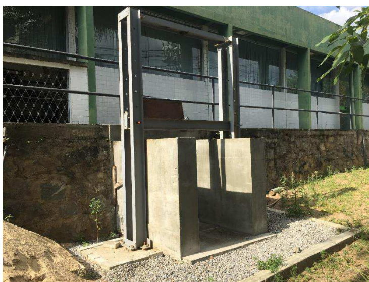
Figura 32 - Conjunto formado pela caixa de concreto do modelo e o pórtico metálico do sistema de aplicação de sobrecarga.
