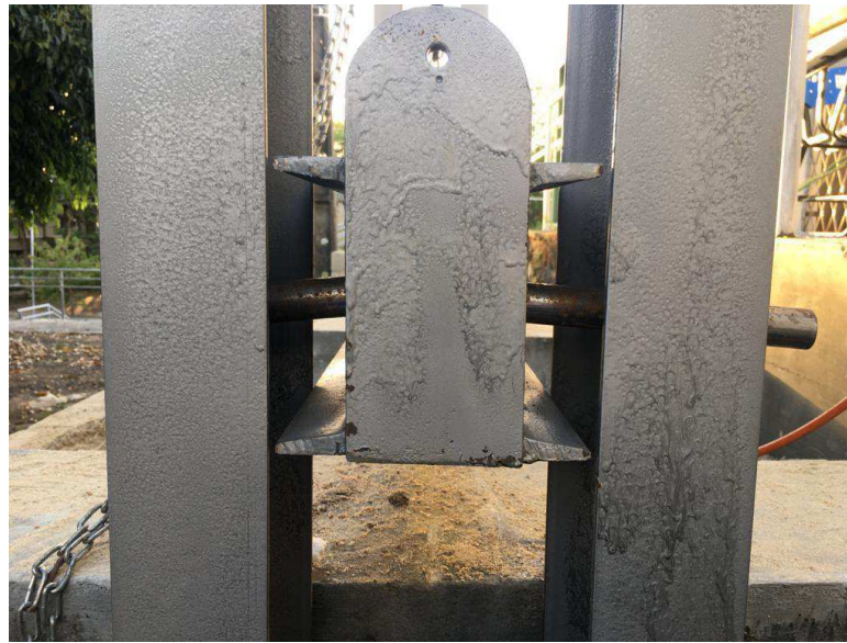
Figura 47 - Barra de fixação da viga de reação retorcida após aplicação de sobrecarga de 8 toneladas.
